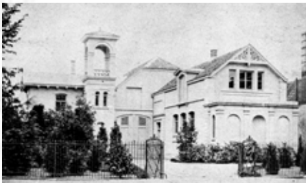
▲ Het ging om een witgepleisterd pand uit 1906 met een curieuze open toren. Die verwantschap vertoont met de 'Italiaanse villa met toren', waarvan in Nederland maar weinig voorbeelden zijn te vinden. Kenmerkend zijn een onregelmatige hoofdvorm rond een torenvormig volume, flauw hellende, over stekende zadeldaken en een neo-classicistische detaillering. Misschien is Stuivinga bij het ontwerpen van het raadhuis en het postkantoor wel geïnspireerd geraakt door de genoemde toren. Hij een traditie voortgezet. Het kantoorgebouw op de hoek Jufferstraat had eveneens een toren. Collectie Het Utrechts Archief.
