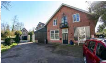
▲ Lageweg 1, de voormalige slagerij.
